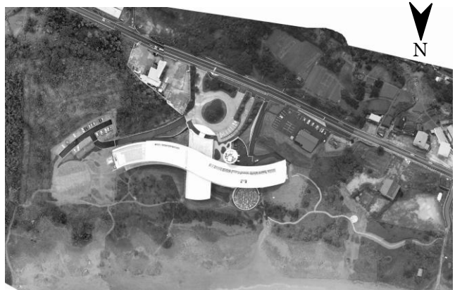
写真-3 整備後の計画地の全景
