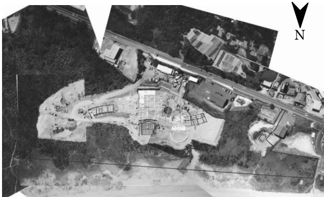
写真-2 整備前の計画地の全景
